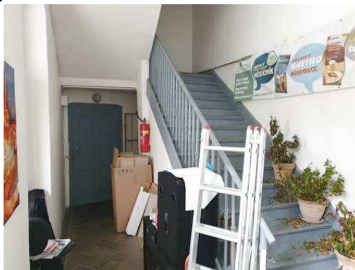
1. NP - schod. hala-chodba
